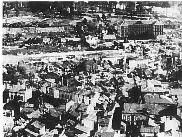
Moissac après la crue
